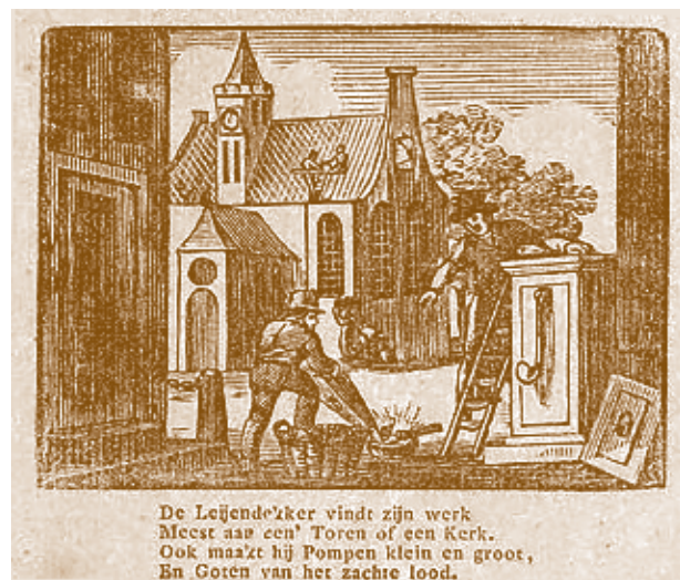
Detail van een centsprent uit het eerste kwart van de 19de eeuw met afbeeldingen van werkzaamheden in de bouw. Op het dak van de kerk op de achtergrond zijn twee leidekkers aan het werk en op de voorgrond maken twee anderen een waterpomp. (Koninklijke Bibliotheek)
